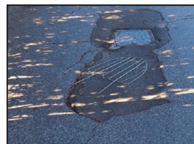
Materiale caduto dal cassone
