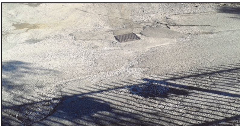
Fondo stradale all'incrocio tra via della Pace e centro commerciale La Miniera
