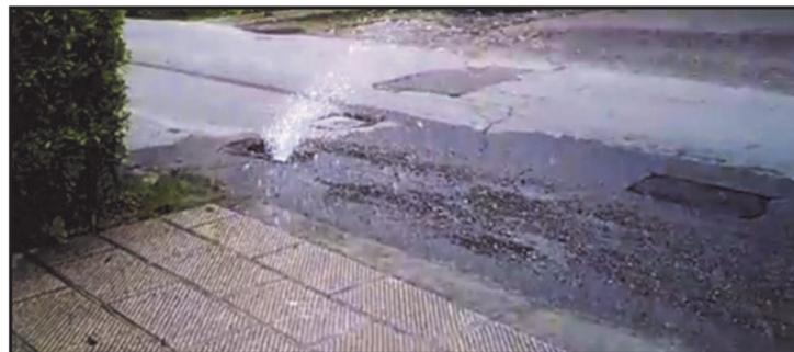
**Sistematica rottura dei tubi dell'acquedotto dovuto all'eccessivo peso dei mezzi che operano nell'isola ecologica.**
