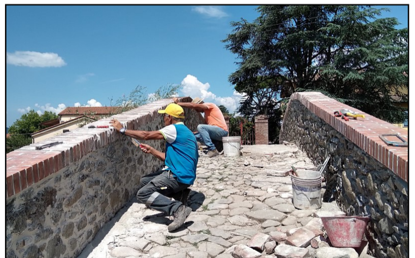
Operai al lavoro per il restauro dei muretti del ponte
