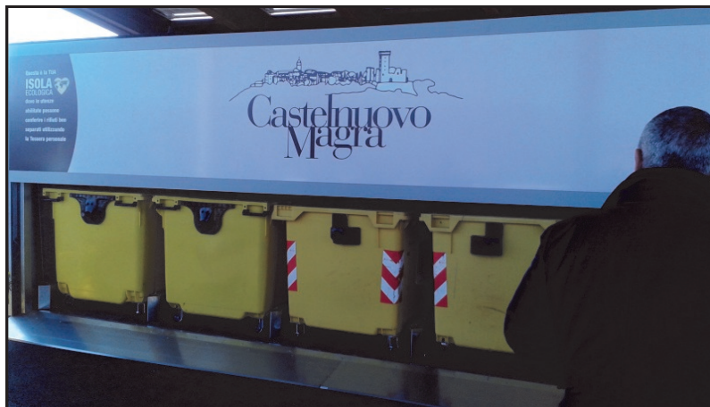
I cassonetti all'interno dell'impianto
